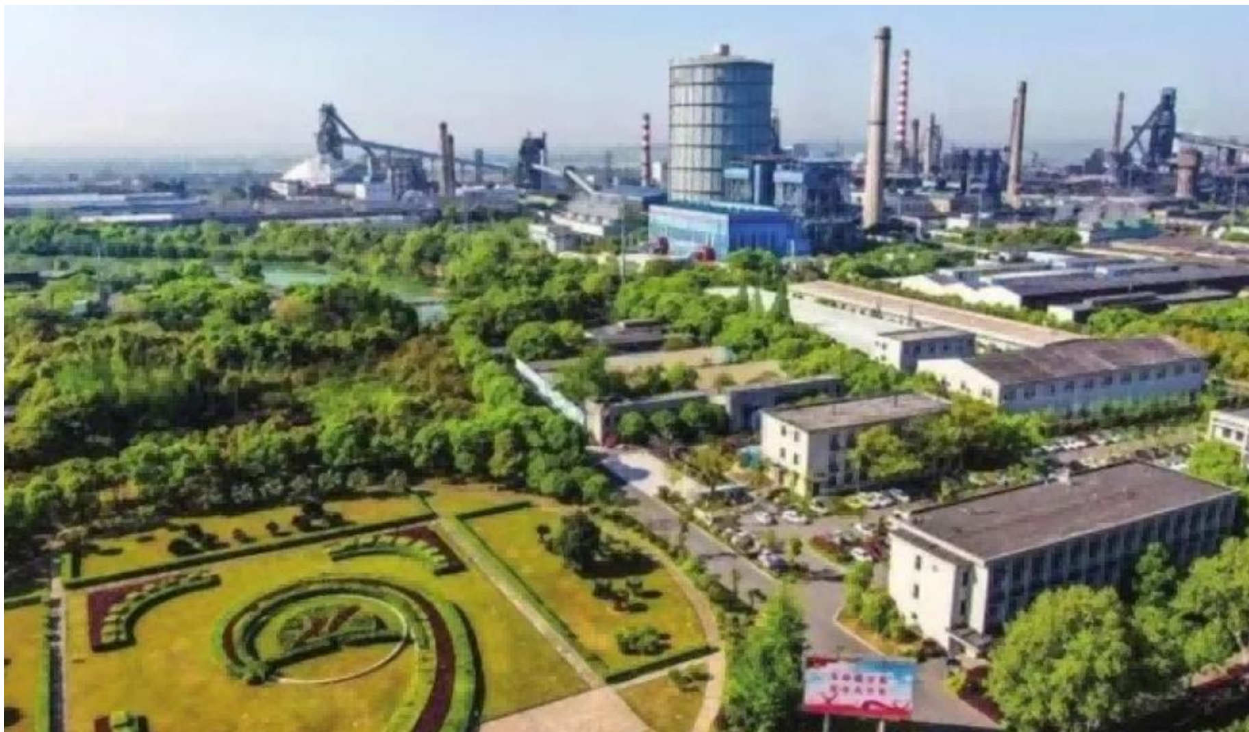
湖南钢铁湘钢厂区
