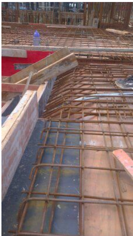
6、斜梯板处纵筋上下锚固位置需注意
