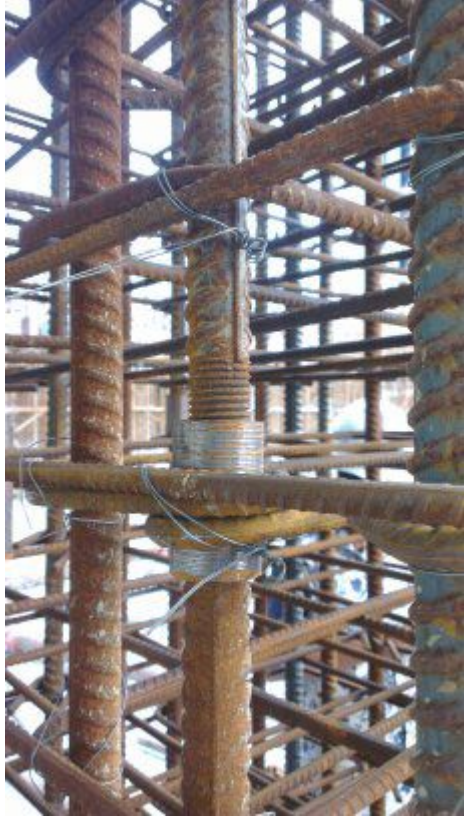
9、纵筋套筒连接露丝过长，套筒尺寸是否正确
