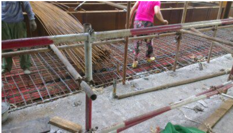
10、后浇带或施工缝处标高控制
