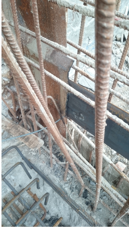
27、坡道止水钢板要连续密实
