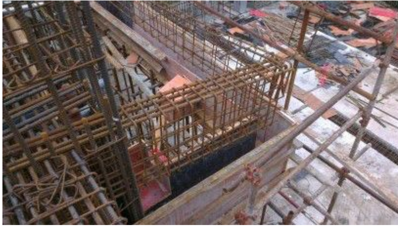
21、悬挑梁下排筋是否上弯，与悬挑端长度有关
