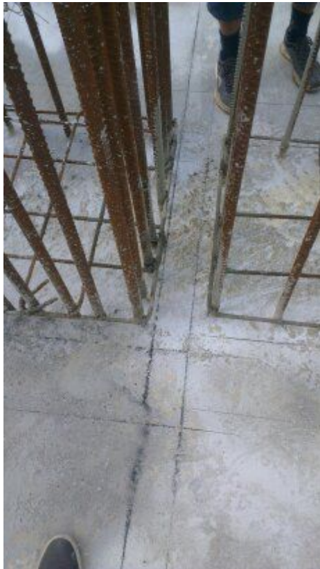
8、无定位筋主筋偏位
