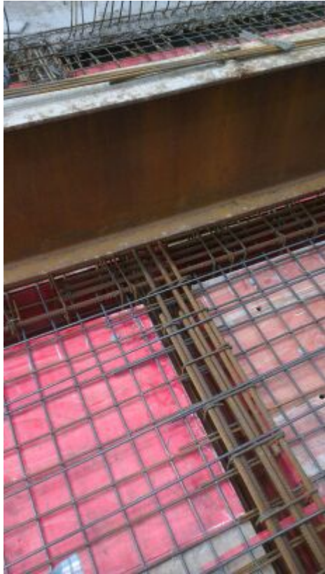
1、根据建筑说明确定钢筋搭接，允许搭接直径范围，搭接长度
