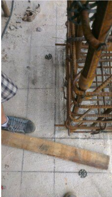
17、主筋定位筋
