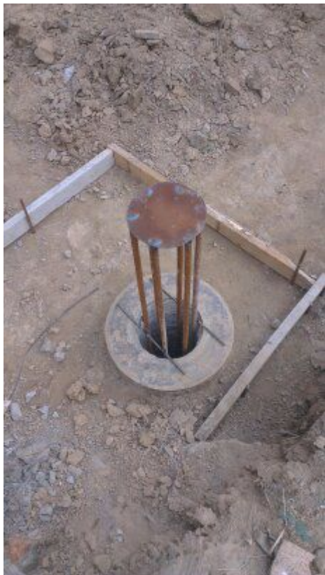
26、预制桩承台桩心
