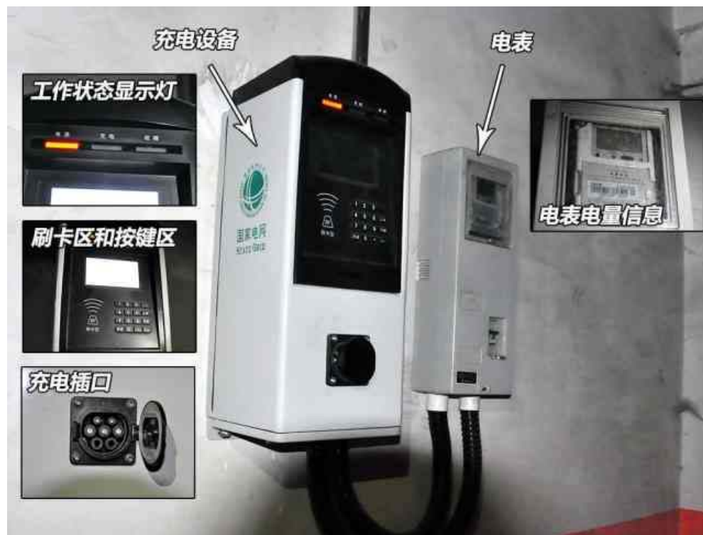
图6-1-10 壁挂式充电桩
