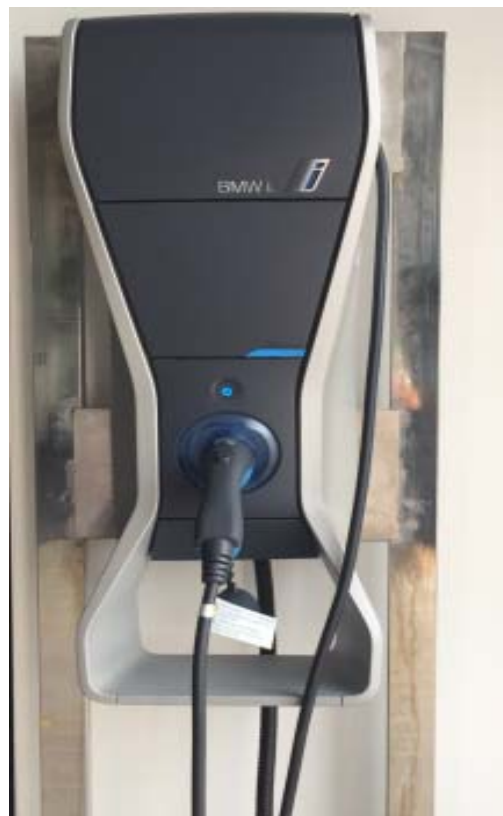
图6-1-14家用车库壁挂式充电桩
