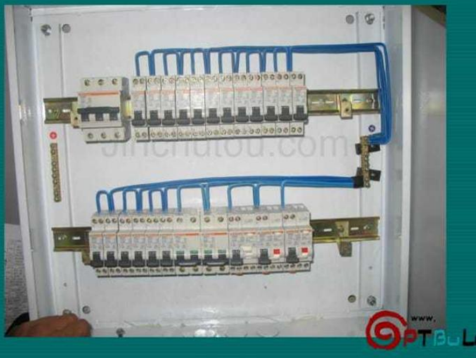
空开零线配线照片（第二排）：
