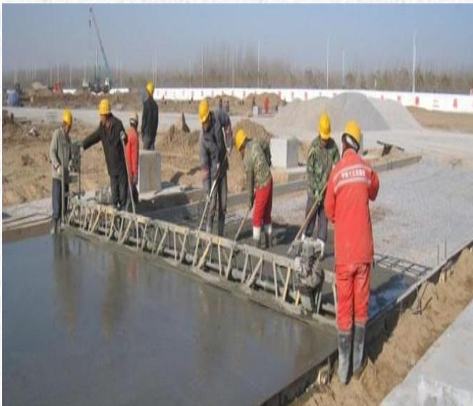
图6-2 小型机具施工-b
