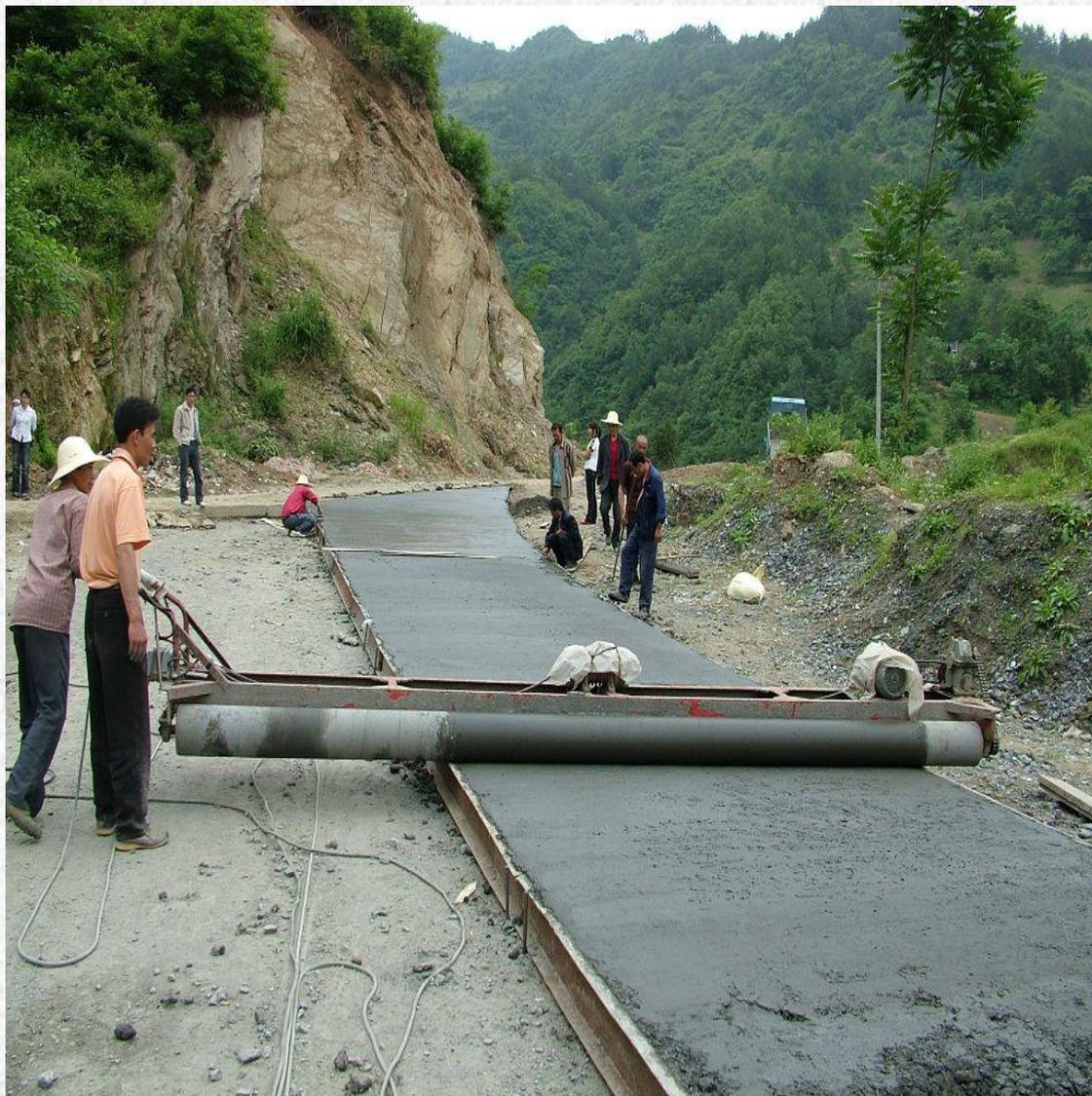
图6-2 小型机具施工-a
