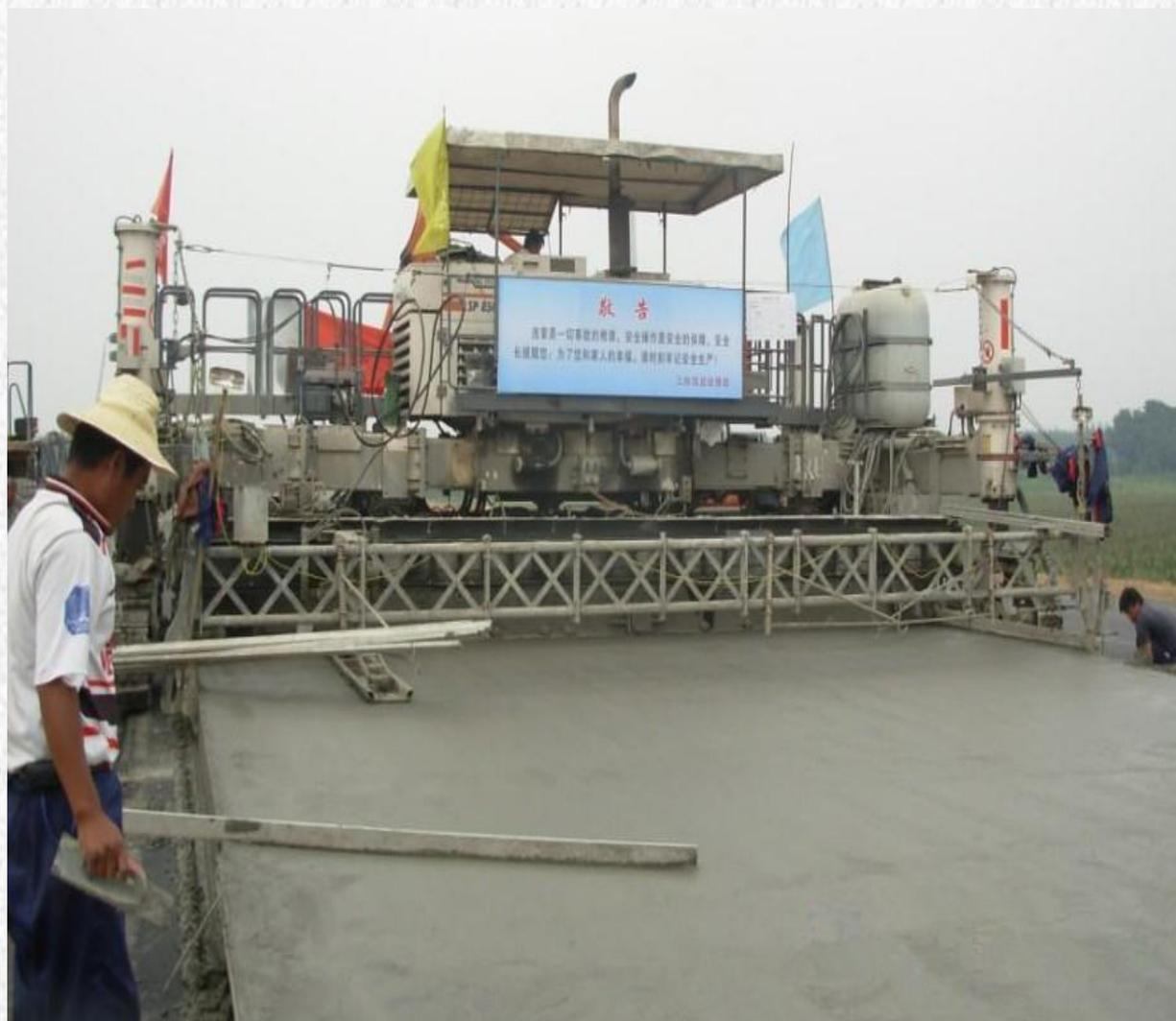
图6-6 滑模摊铺机施工
