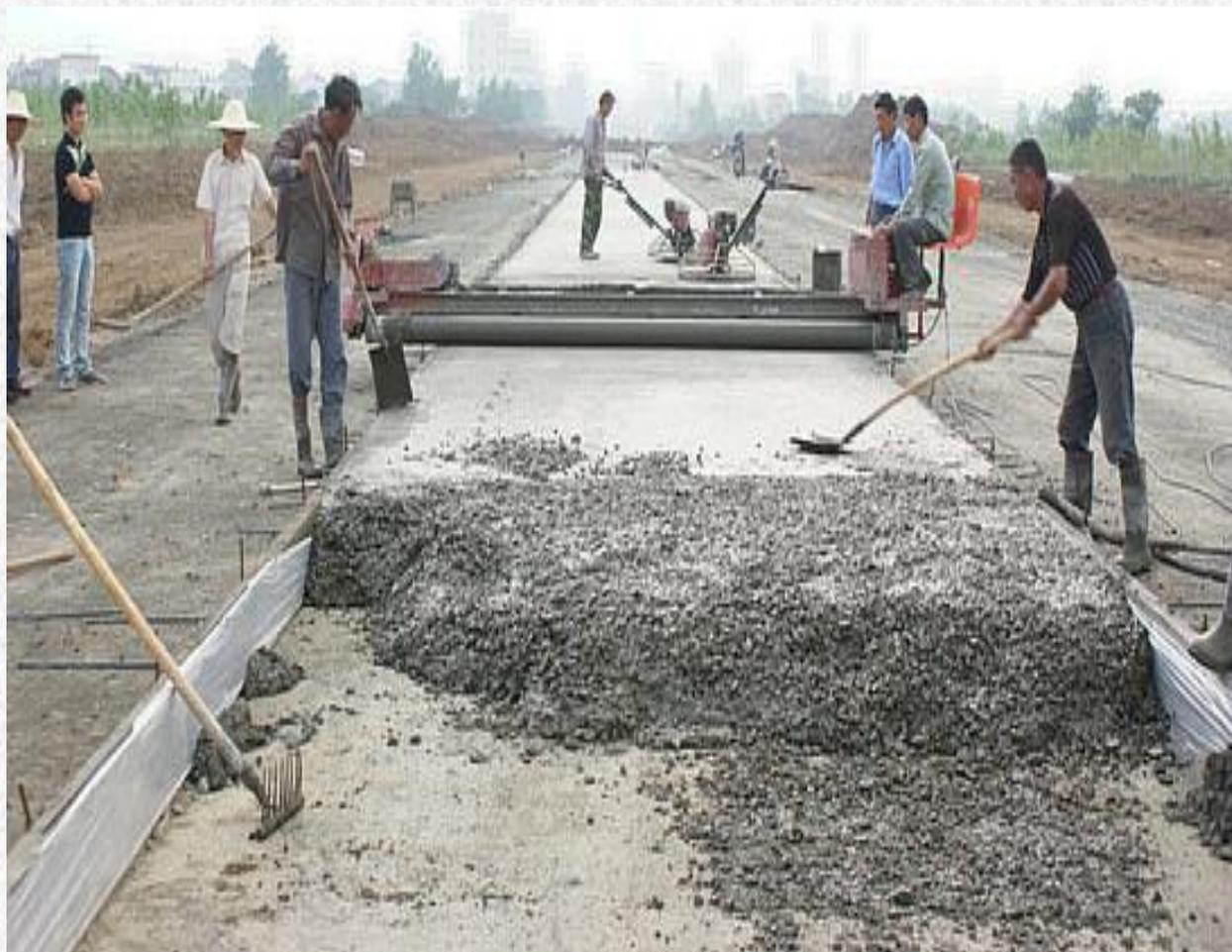
图6-3 三辊轴机组施工
