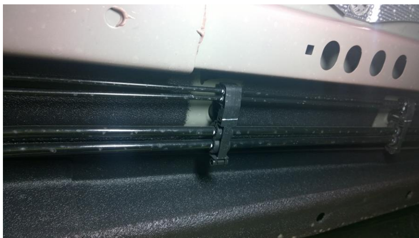
图 2-50 燃油管路安装支架检查
