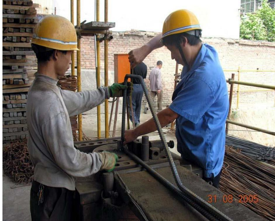
工人在控制弯起钢筋的下料
