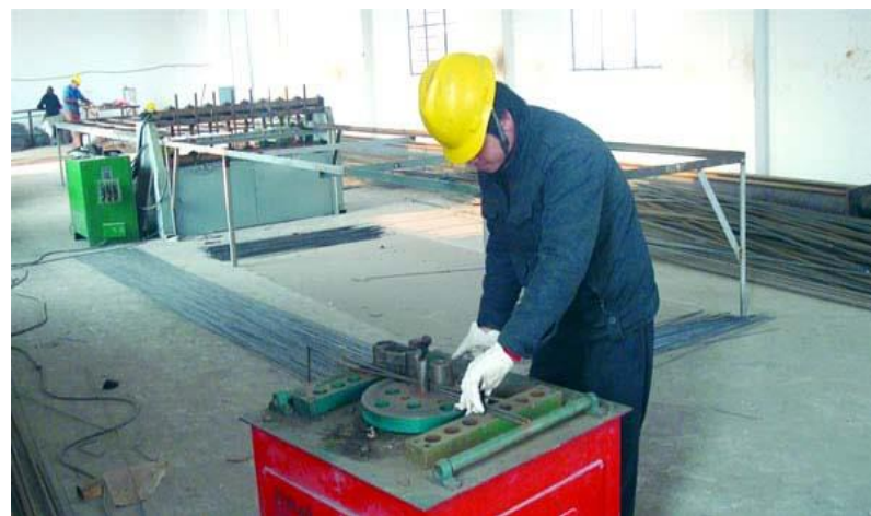
钢筋工弯曲钢筋实景
