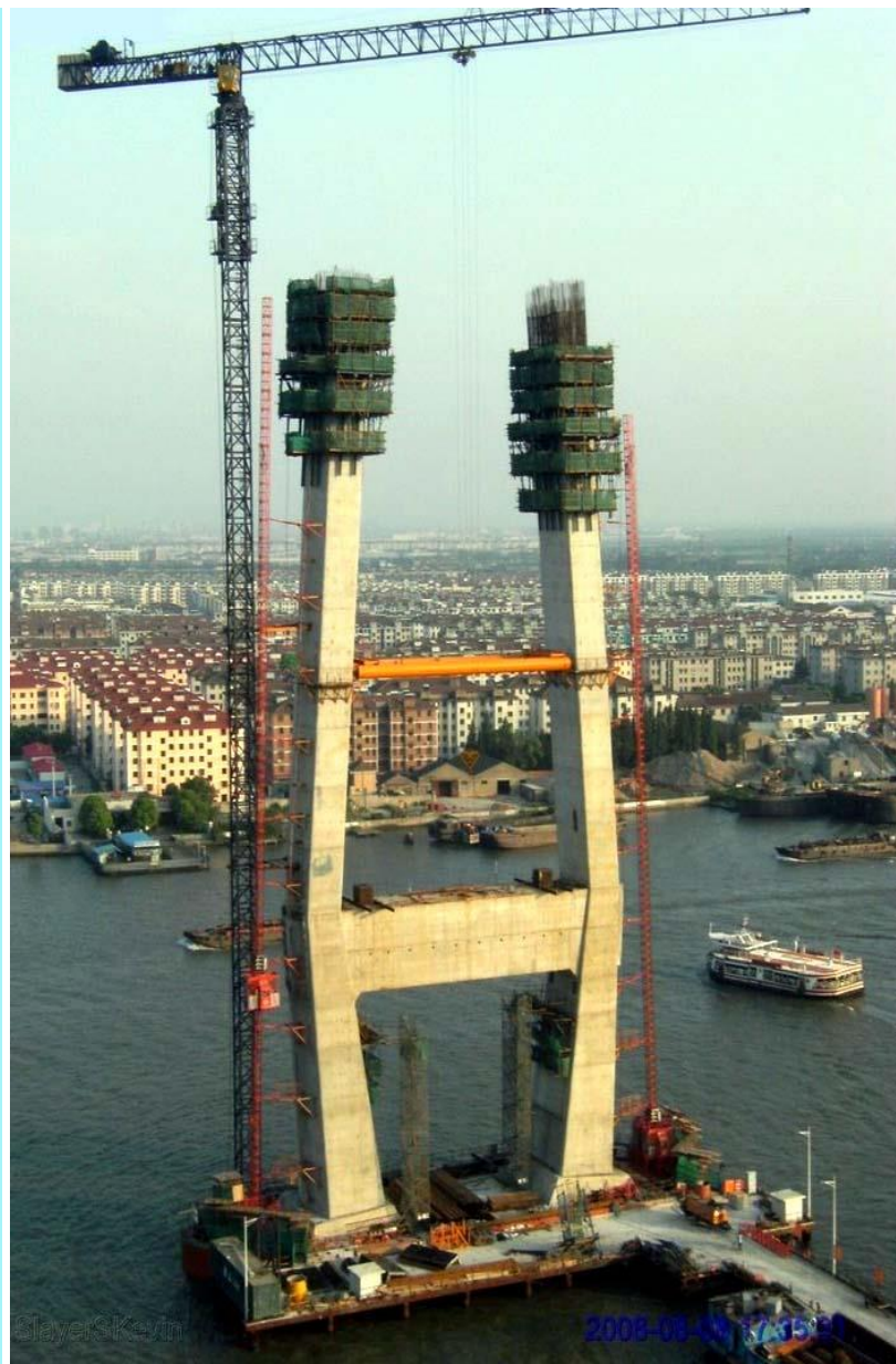
爬模工艺施工桥塔
