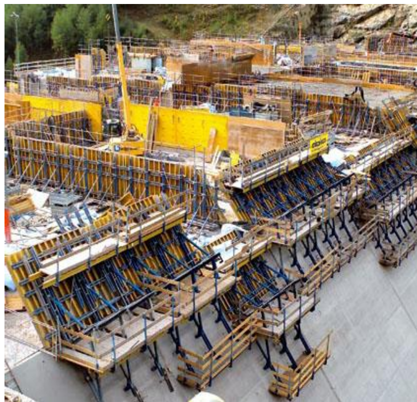
施工中的悬臂模板及支架
