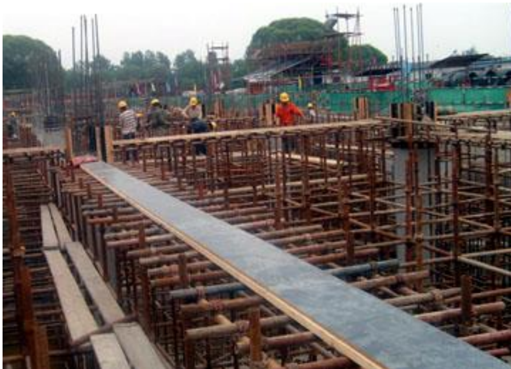
梁底模板及支架
