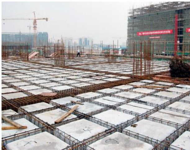
密肋楼板模壳安装
