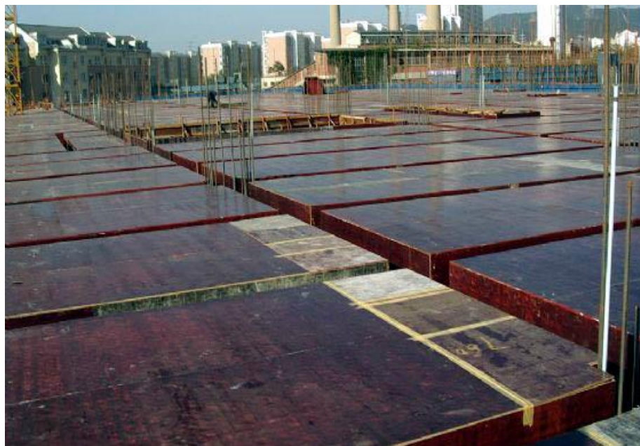
竹胶合板模板铺设楼面模板
