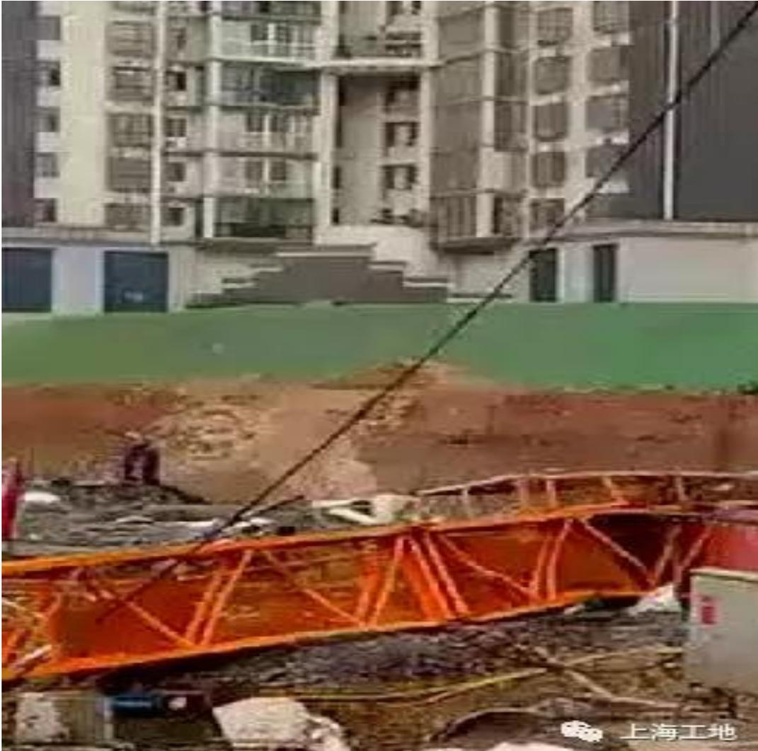
2017 年 12 月 5 日上午 7 时 58 分，湘乡市东山街道霞光名府工地上，发生一起塔吊安装倒塌事故，根据现场照片视频勘测又是顶升爬架与下支座没有用销轴或螺栓连接，造成 1 人死亡，1 人受伤。
