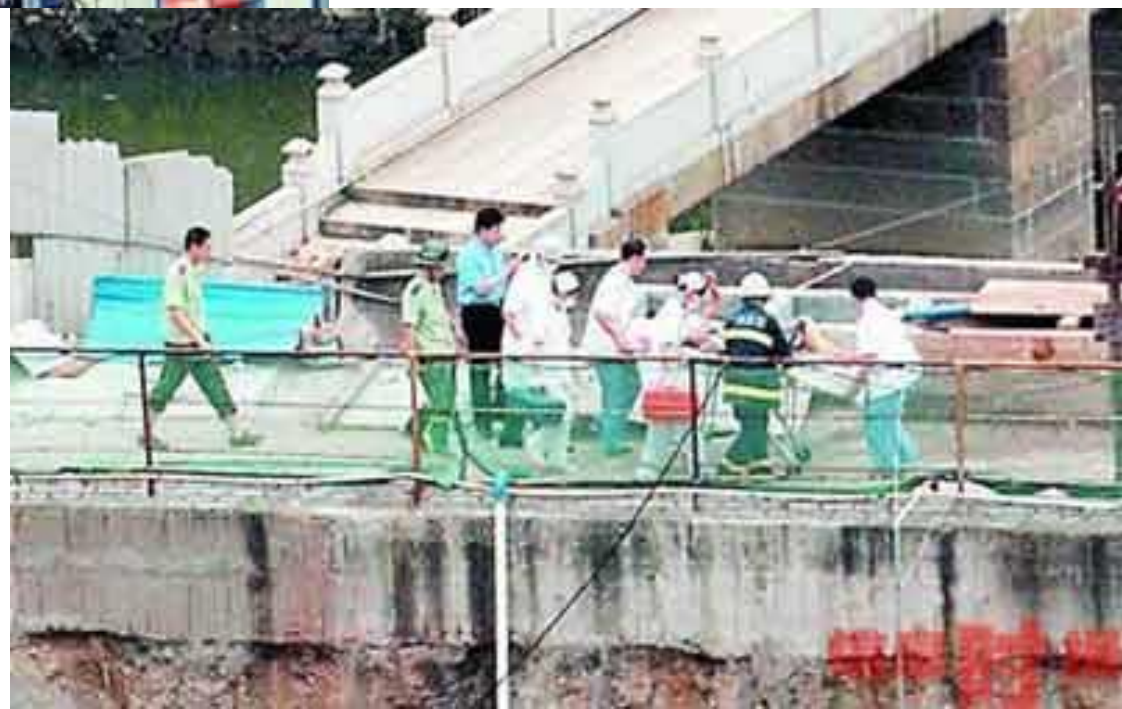
右图：救援人员在塌楼现场紧急抢救在事故中受伤的工人
