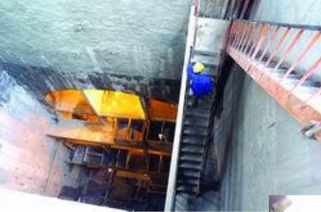
左图：俯瞰5号线地铁坑道竖井
