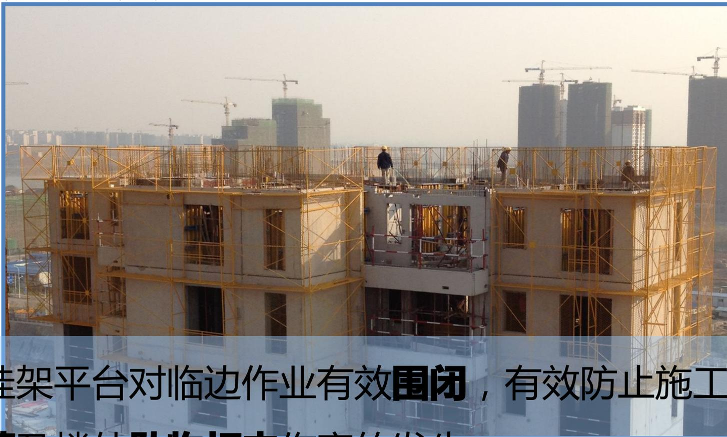
✓ 外挂架平台对临边作业有效**围闭**，有效防止施工层**人员坠落**及楼外**坠物打击**伤害的发生。
