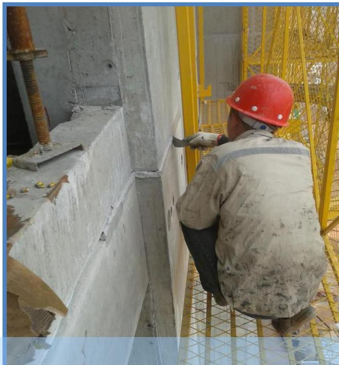
✓ 利用外挂架平台进行外挂板横缝、竖缝打胶收口，减少一部分吊篮作业。
