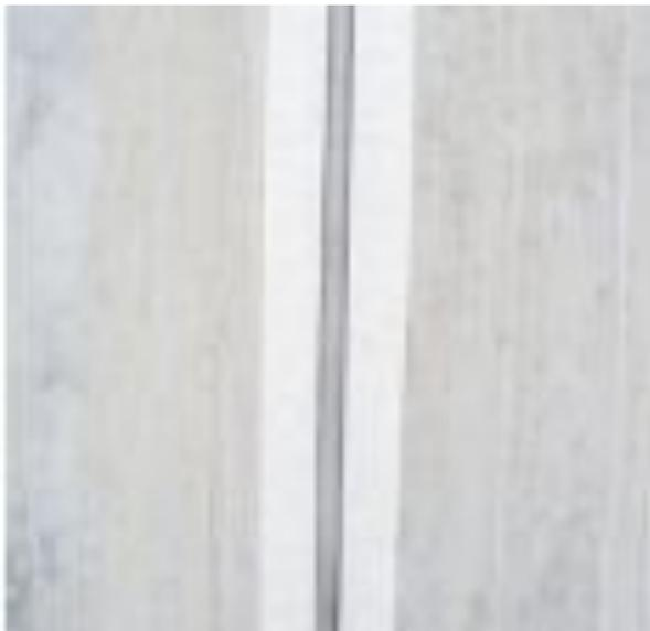
在位移量较大的地方（如：横缝和竖缝的结合处），以及易松动或易开裂的混凝土表面施工底涂 Sika®
