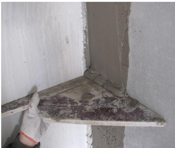
阴角处施工，应用定做的直角板最后刮平一次，保证阴角的方正。
