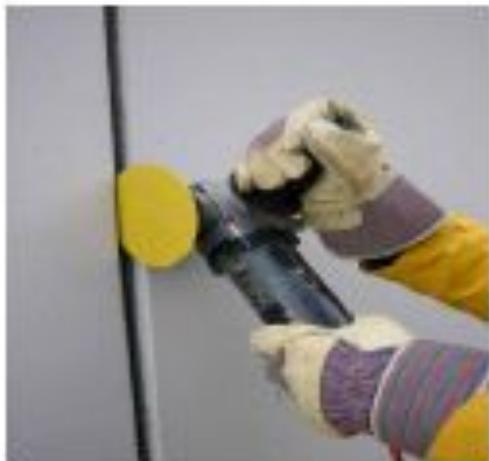
a. 通过角磨机或钢丝刷去除不利于粘结的物质，如：油脂，灰尘，油漆，水泥浮浆和其他不利于粘接的微粒；
