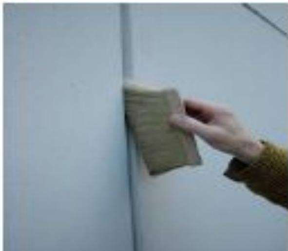
b. 用毛刷或者真空吸尘器清洁基材表面上由于打磨而残留的灰尘、杂质等，保证基面干净、干燥、结构均一；
