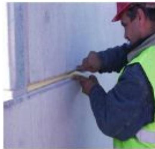
b. 用背衬材料控制密封胶的施胶深度（通常情况下，背衬材料应大于接缝宽度的 25%），实现宽深比 2 : 1 或 1 : 1（根据实际接缝宽度而定，参见“ I .接缝设计”）；
