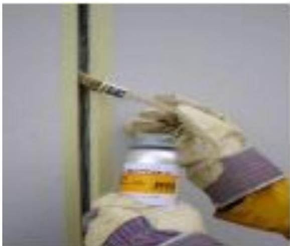
c. Sika®Primer-210 在低于 15° C 条件下需晾置 30 分钟，高于 15° C 的条件需晾置 10 分钟（详细操作时间可参阅 Sika®Primer-210 技术说明书），请务必保证打胶前底涂已完全干燥；
