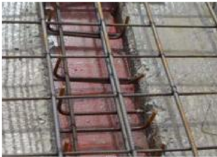
水平钢筋搭接连接
