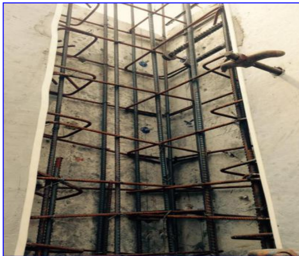
竖向构件后浇混凝土
