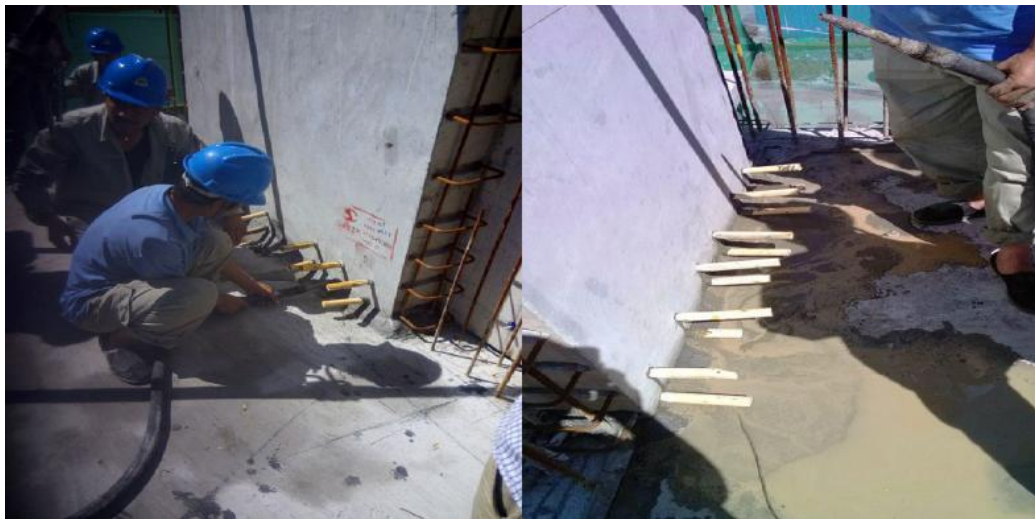
剪力墙竖向钢筋套筒灌浆连接
