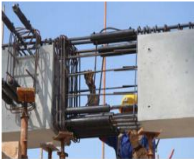
水平钢筋灌浆套筒连接
