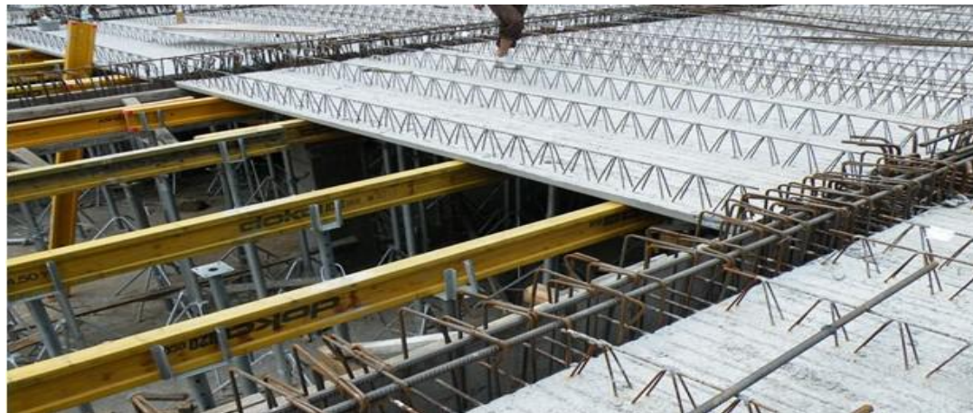
水平构件后浇混凝土
