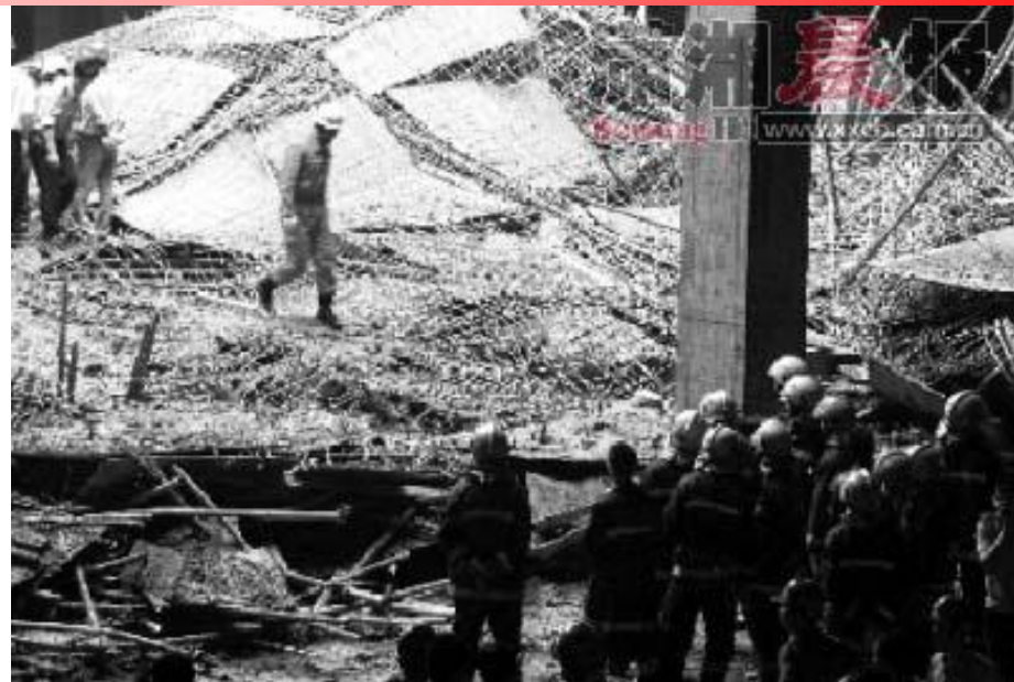
坍塌现场照片
