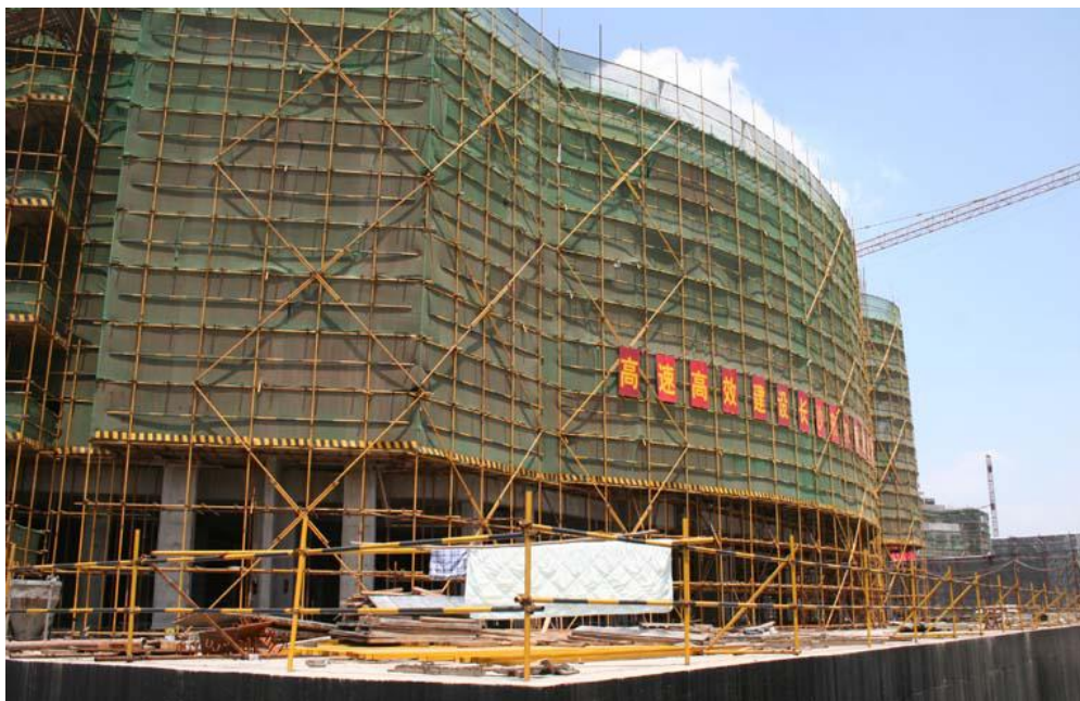
上河国际商业广场 施工中的
